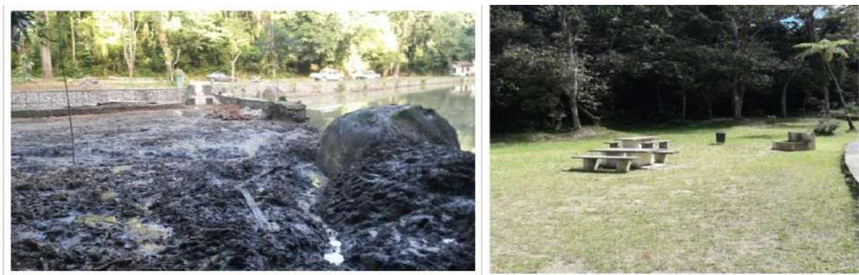
Figura 63: Revitalização e limpeza do Açude.
