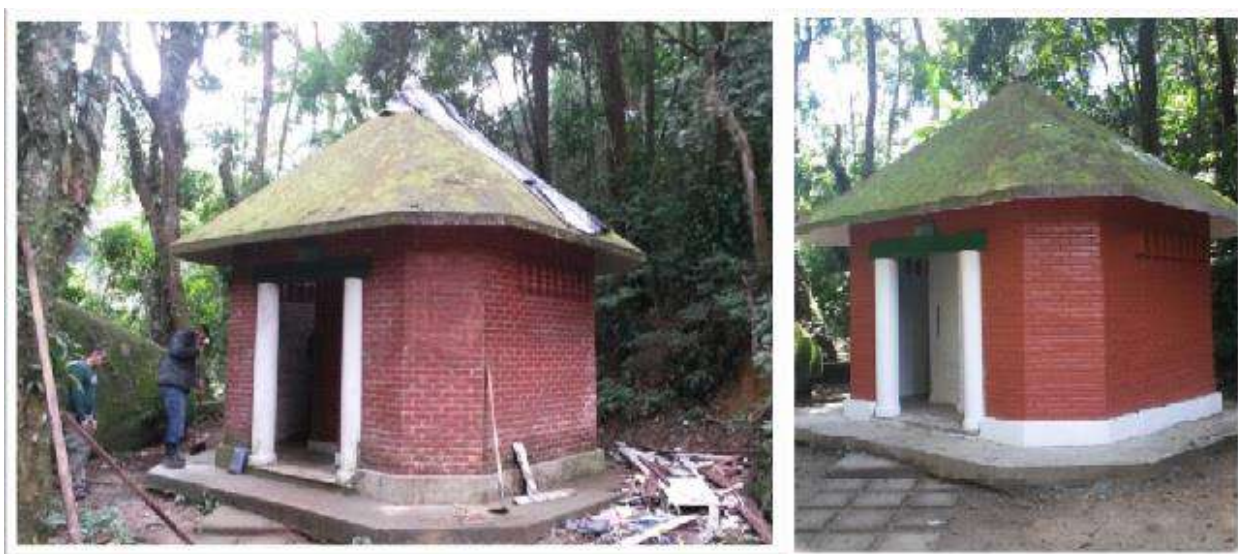
Figura 64: Reforma dos banheiros e escadas do Açude.
