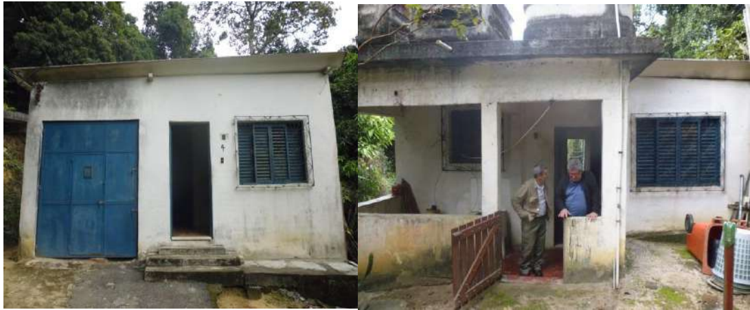
Figura 36 – Imóvel devolvido no Setor Serra da Carioca.
