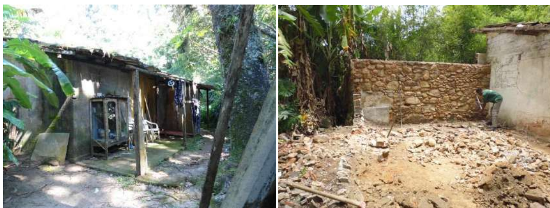
Figura 35 – Casa demolida na Fazenda.
